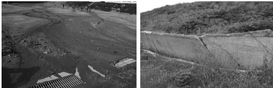
그림 6. 연병장에서 토사가 유출되는 모습(좌, 2007.9)과 연병장 주변 토사유출 방지벽이 무너질 듯 기운 모습(우, 2011.10).
