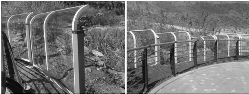
그림 14. 침입방지책 시공 사례 (서울시 양천구 신정3동).
