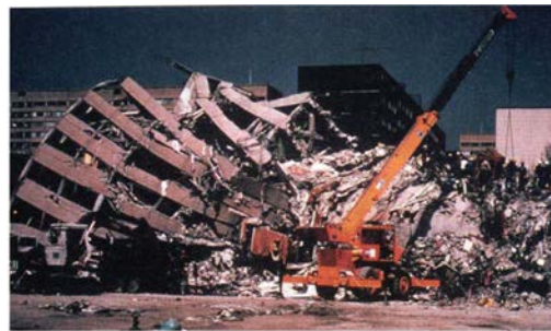
빌딩의 붕괴(1985, Mexico지진) 11)
