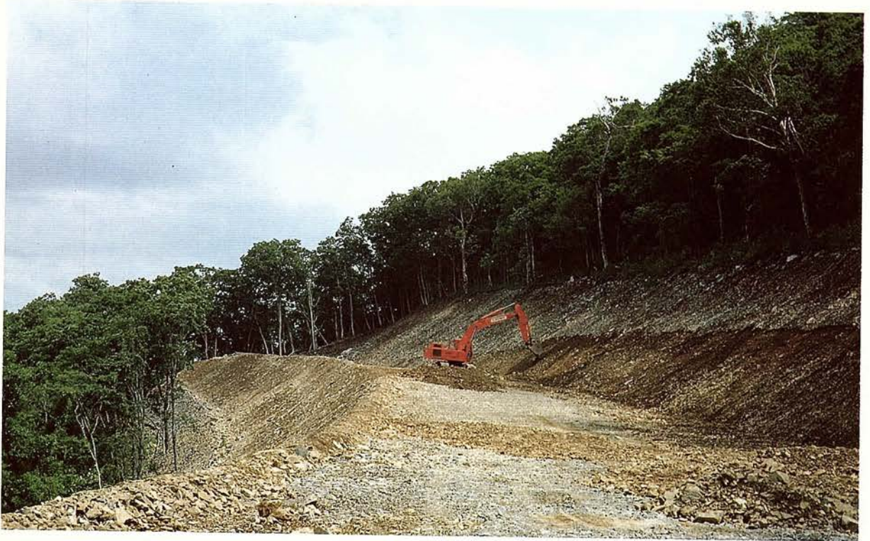
발왕산 동편 슬로프 공사현장
