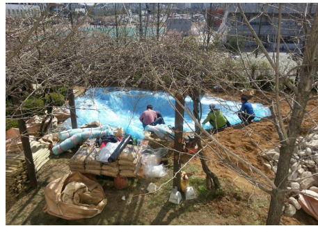
연못 하부 방수포 설치
