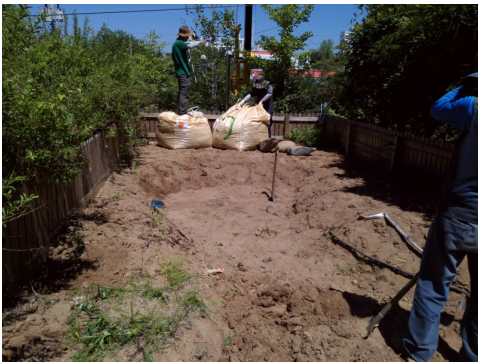
논 습지 설치 공사 현장
