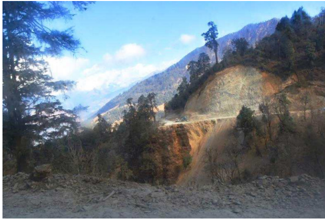
〈그림 4〉 부탄의 도로공사 현장
