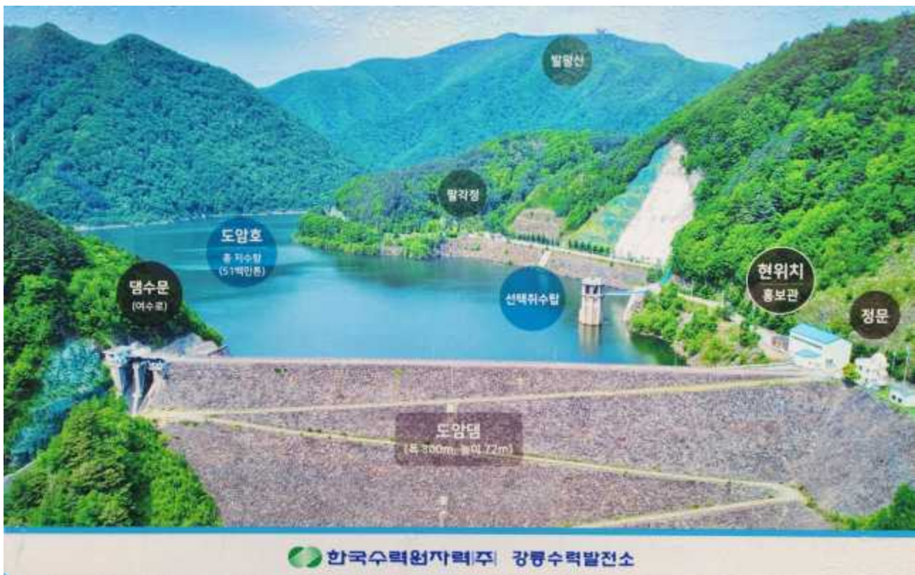
그림 2. 도암호 댐수문, 선택 취수탑 위치 전경
